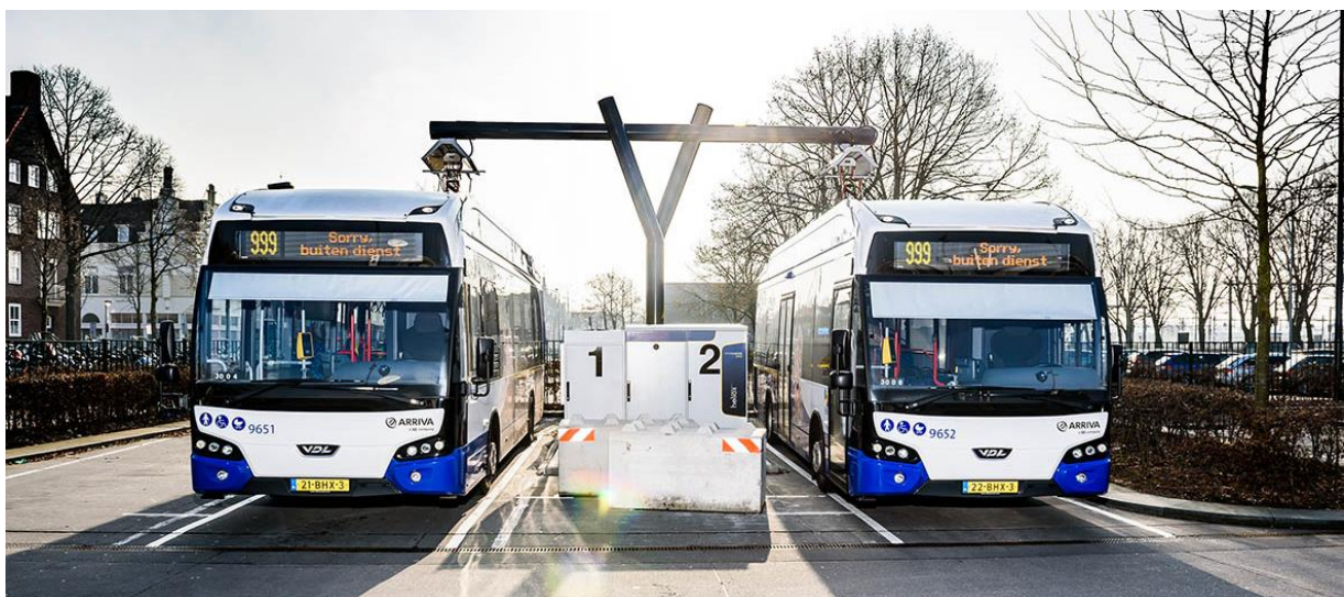
Figuur 3: Laadinfrastructuur met transformatorruimte (Foto: Allego.nl)
