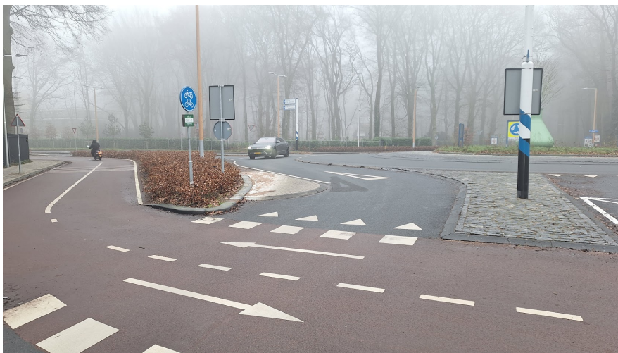
Figuur: Toegepaste aanpassing van de afrit van de rotonde in Ede met overrijdbare versmalling
